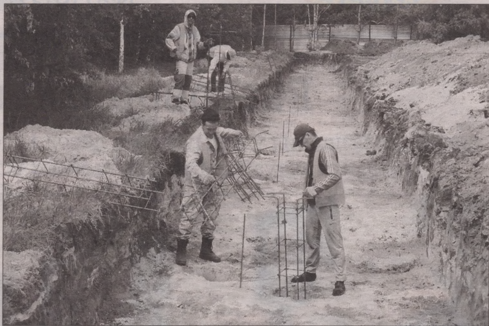
Строительство ФОК идет полным ходом
