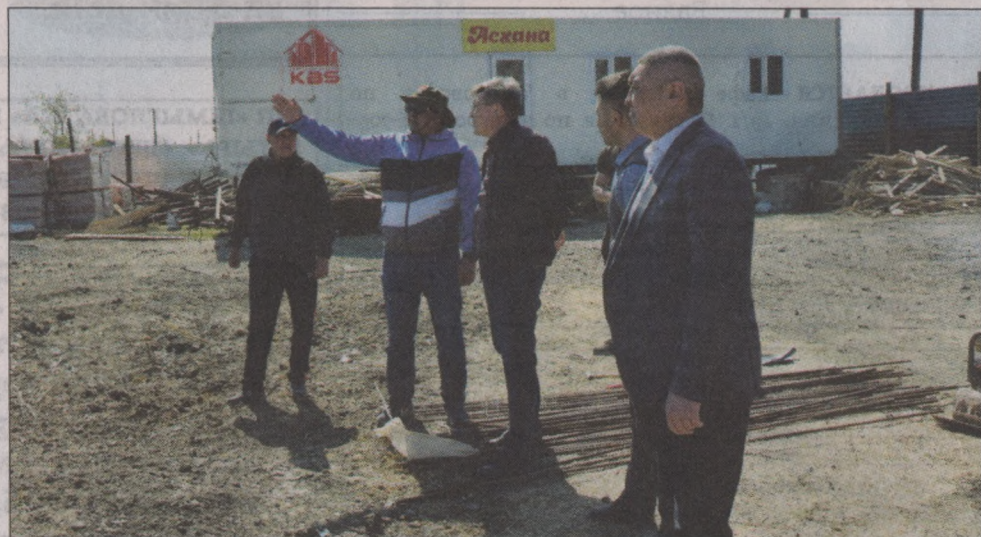
Большой интерес проявляет местная исполнительная власть к ходу строительства новой мечети в с.Боровское
