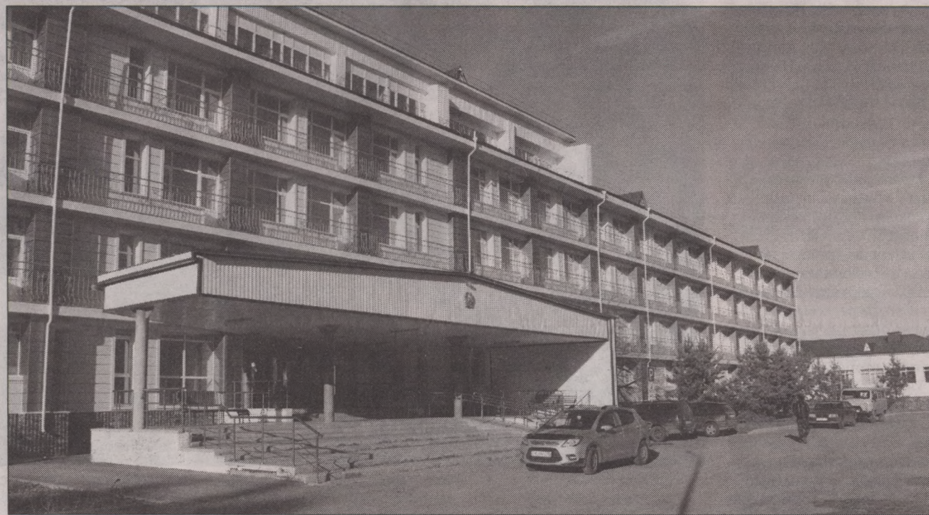
Фасад корпуса при капитальном ремонте был полностью изменен
